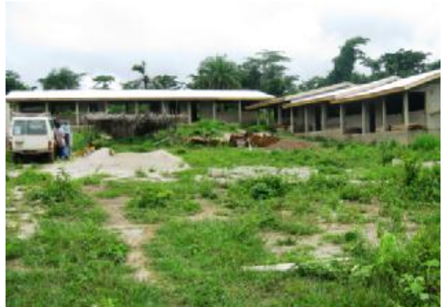
Der Rohbau der Schule ist bereits fertig ...
