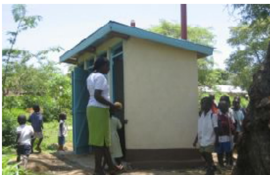
Eine neu errichtete Schullatrine.
