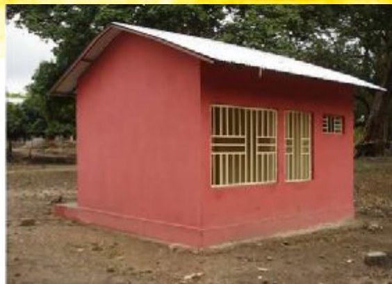
Die neu gebaute Schulküche in Demba Taco.
